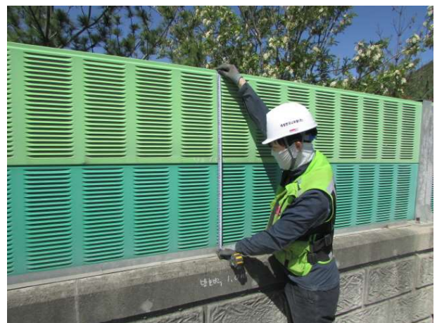
방호벽 부재제원 확인 전경
