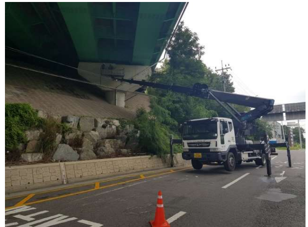
고소작업차를 이용한 현장조사
