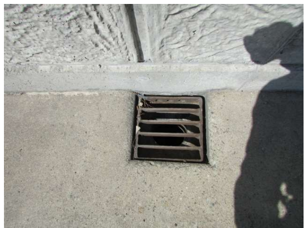
S2 방호벽 균열( C_w=0.2/L=1.0m )
