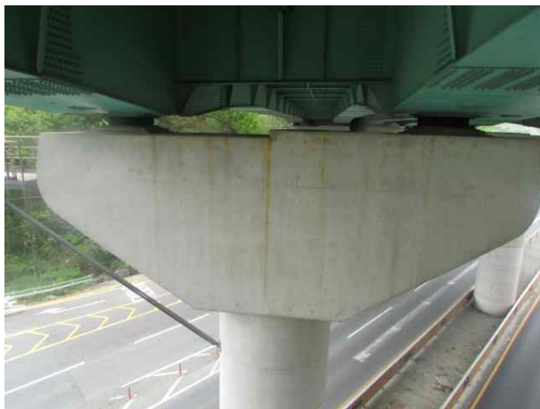
내용 : 교각 코핑부 상태 양호
