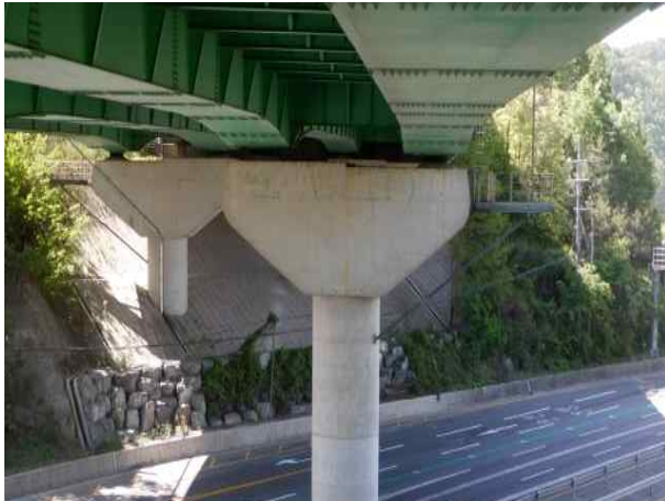
내용 : 교각 코핑부 상태 양호
