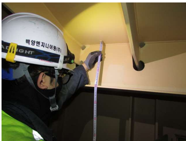
거더내부 부재제원 확인 전경
