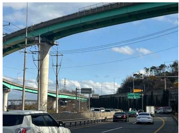
도로 (S1) 전경
