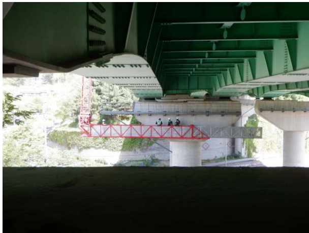
교량점검차를 이용한 현장조사
